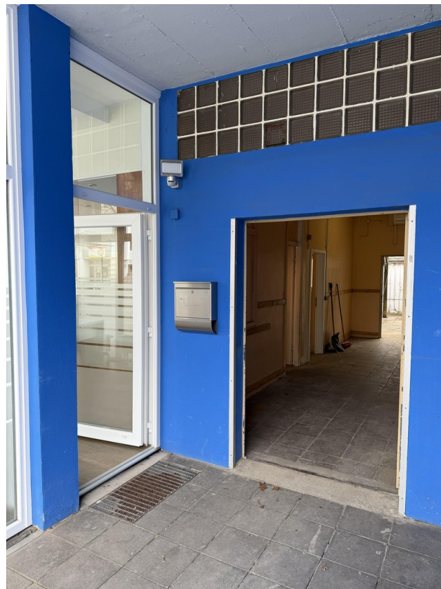
Eingangstüre Büro und Lager
