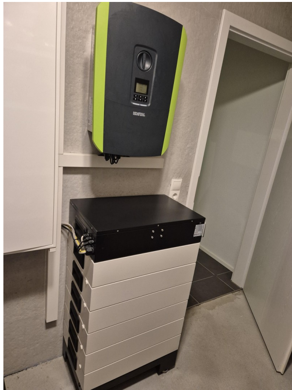
Batteriespeicher PV_UG
