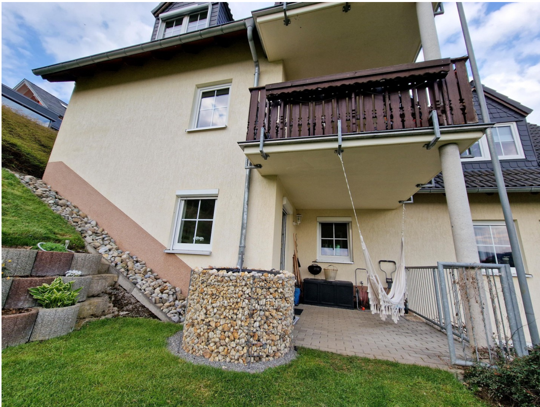
Außenansicht Terasse & Balkon
