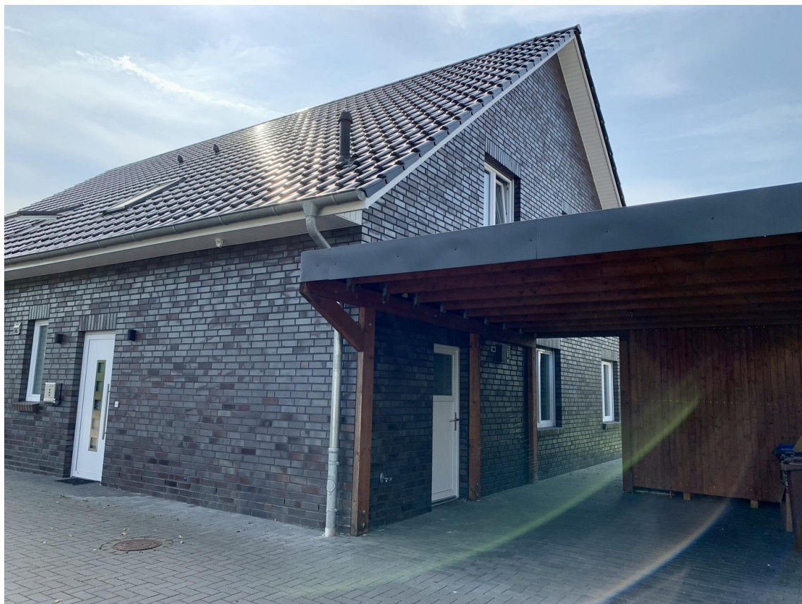
Einfahrt mit Carport
