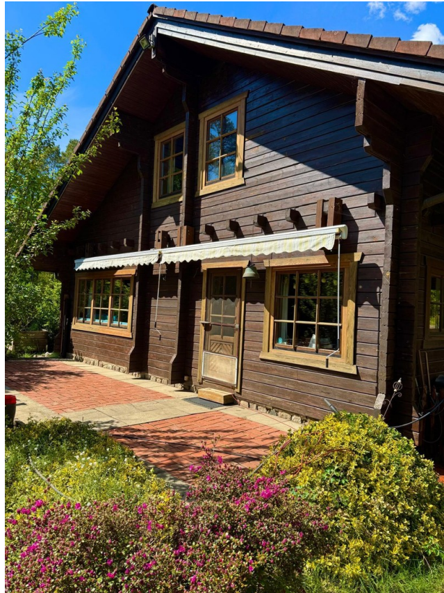
Südterasse von Südosten
