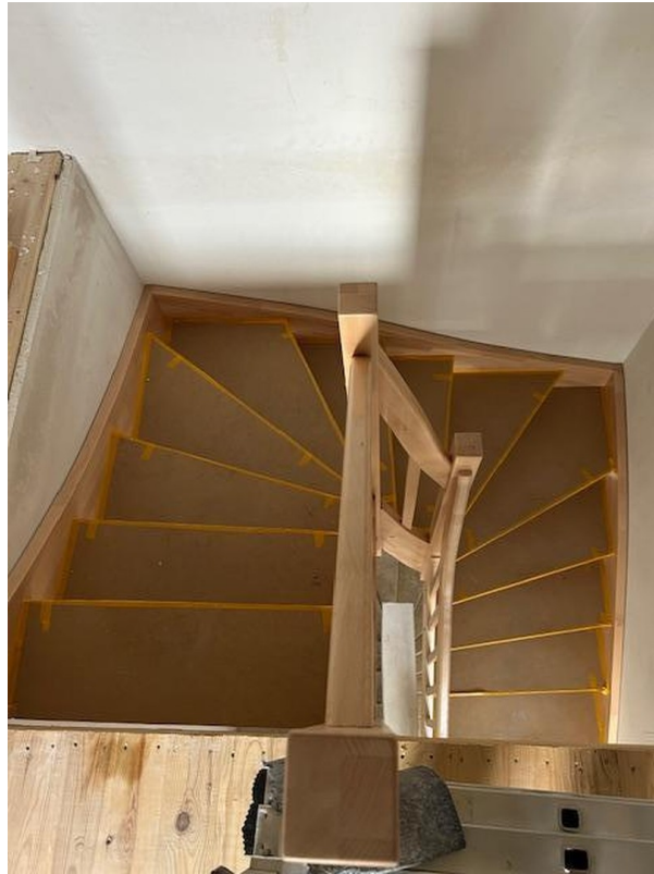
Treppe zum DG
