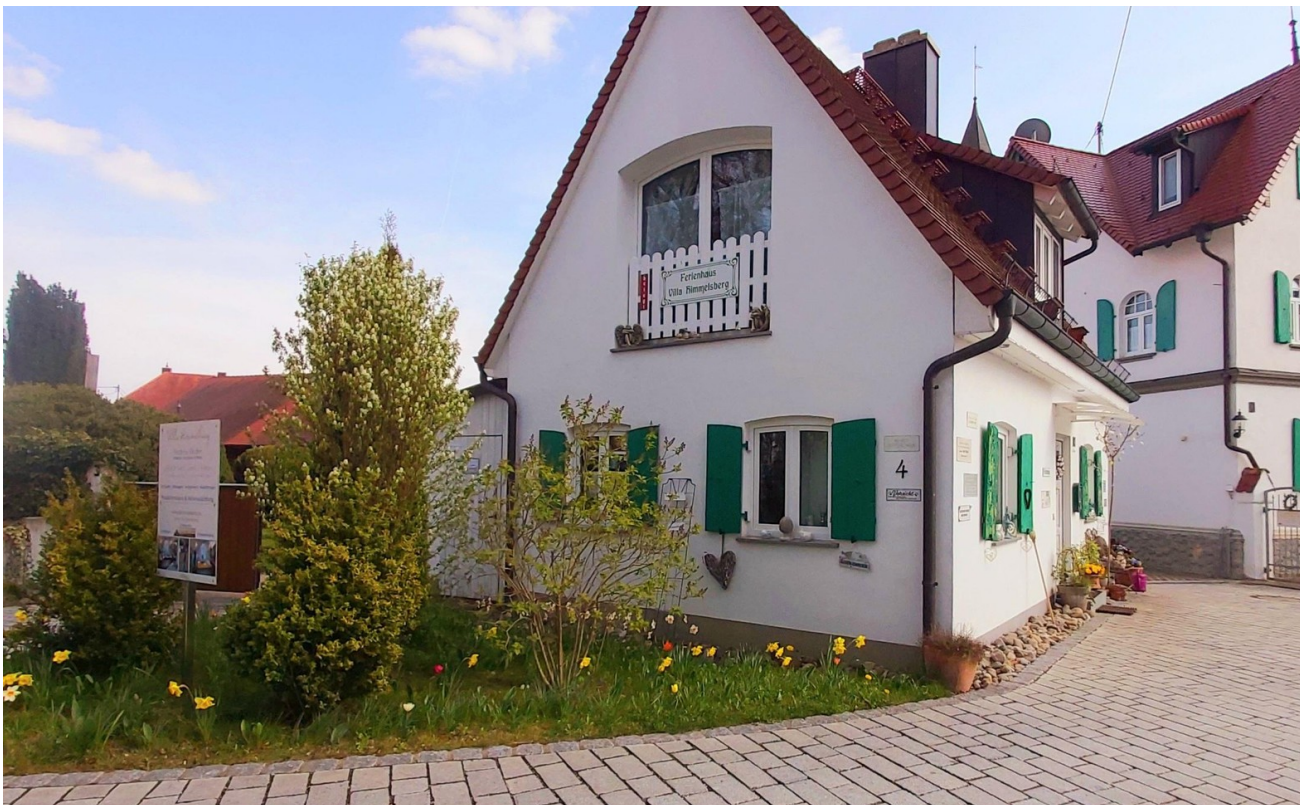
Einfahrt zur Villa
