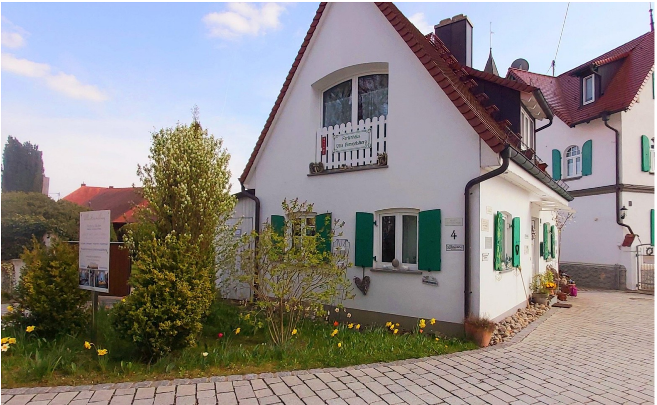
Einfahrt zur Villa
