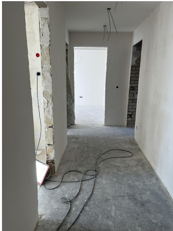
Flur Ist Zustand
