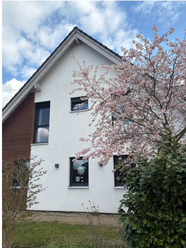
Hausansicht von der Straße
