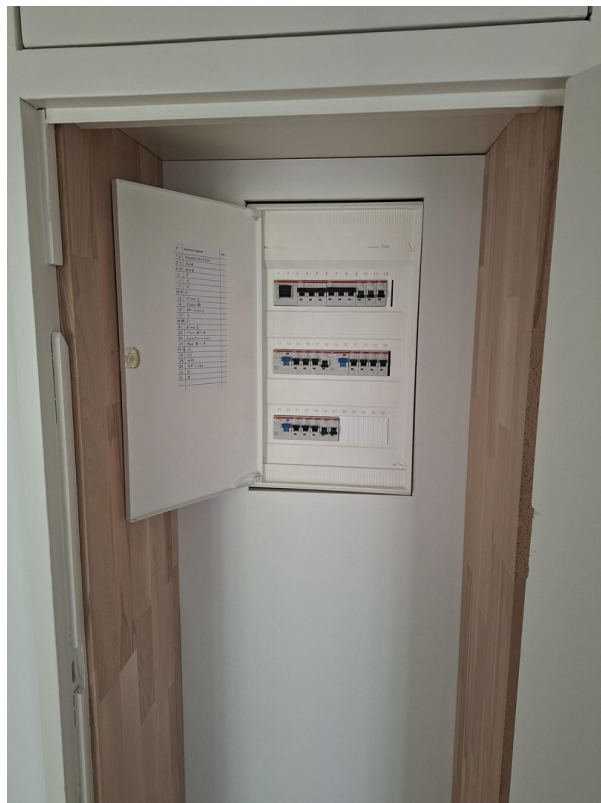
Neuer Sicherungskasten
