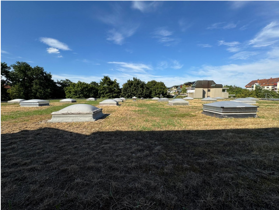
Blick von der Terasse
