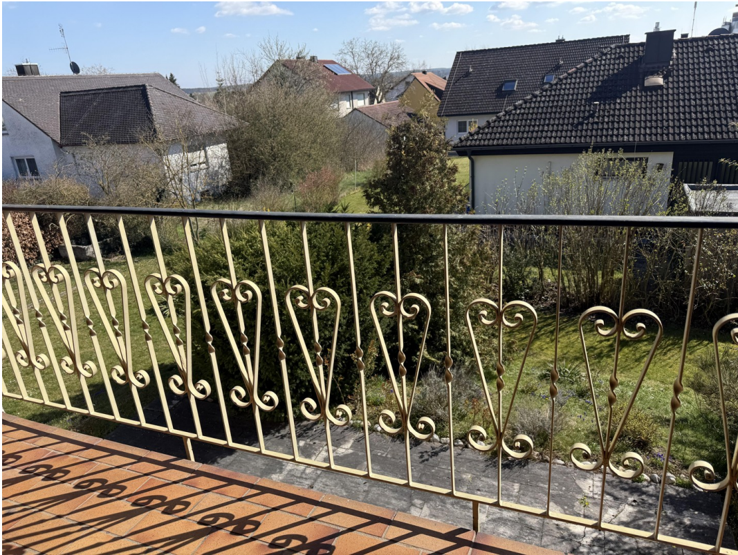
Blick Loggia OG
