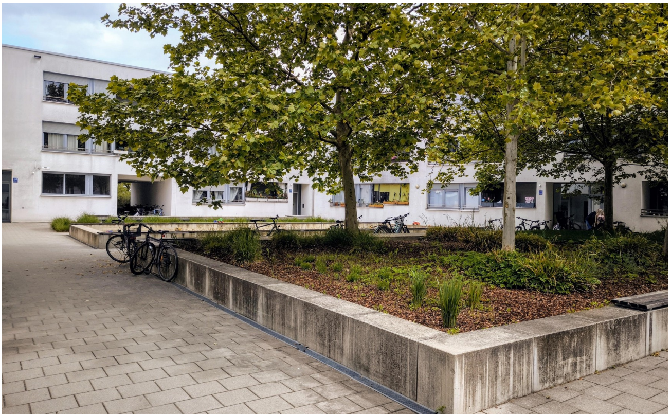
Innenhof mit Hauszugang
