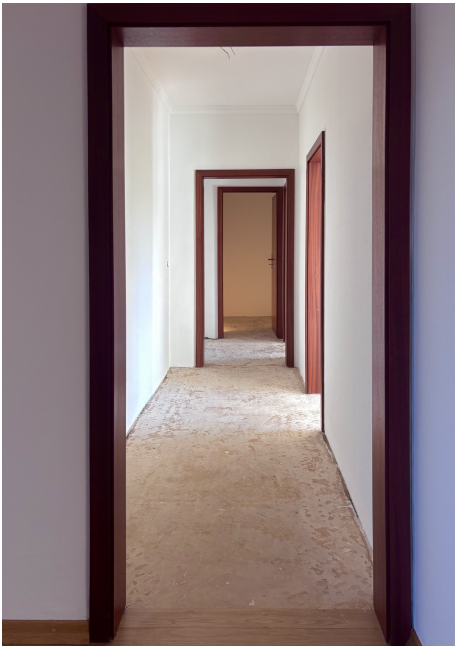
Flur (Neuboden vorbereitet)
