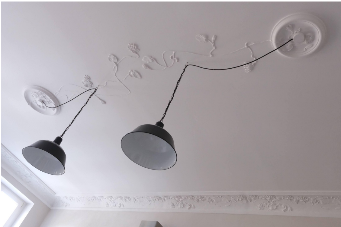
Stuck im Küchenbereich
