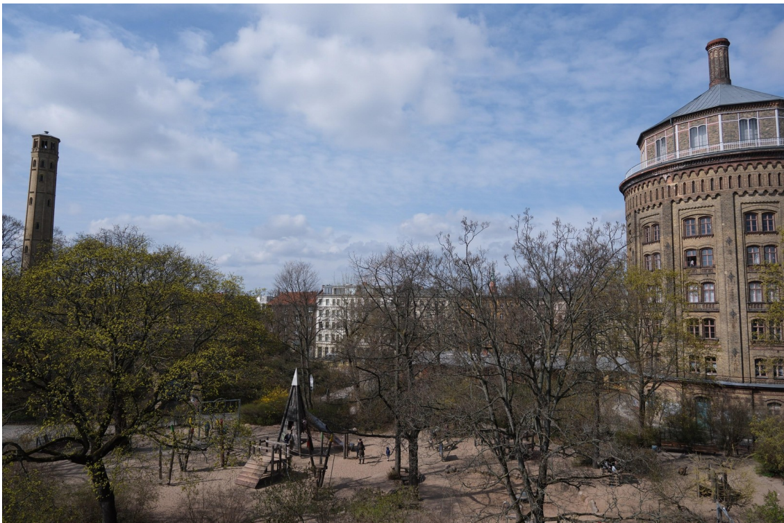
Blick auf den Wasserturm
