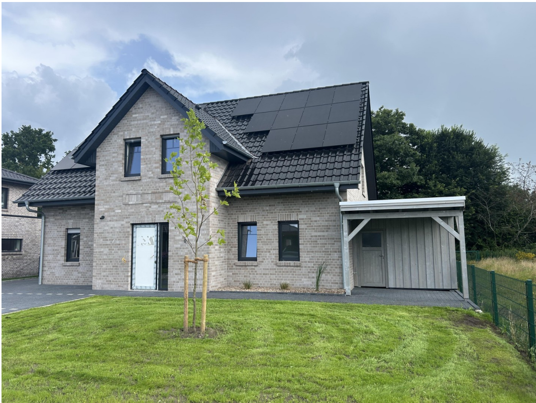
Ansicht vorne, Geräteraum
