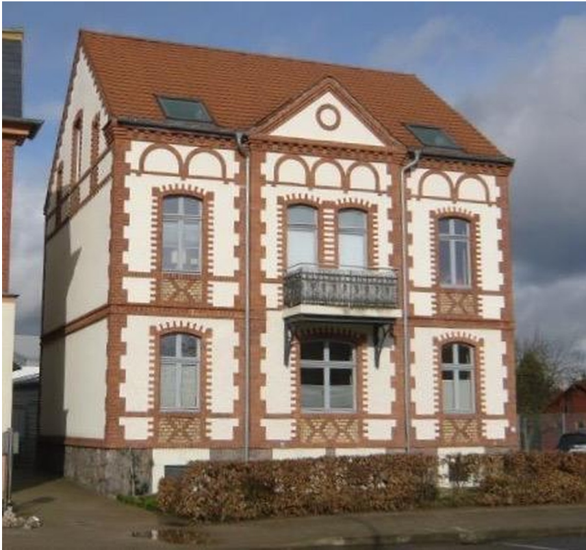
Straßenansicht mit Balkon
