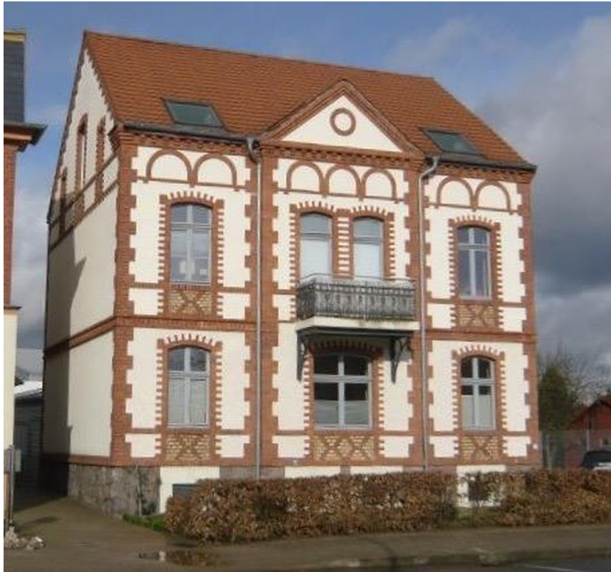
Straßenansicht mit Balkon
