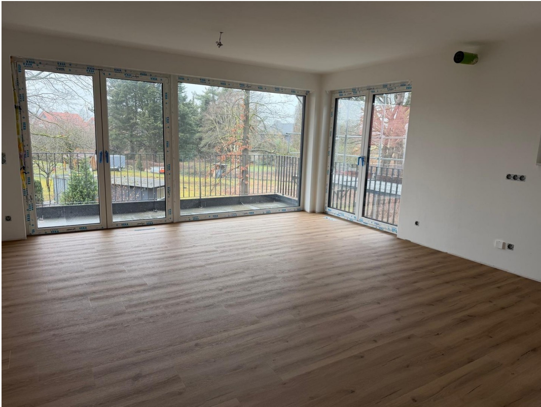
Raum 1 (aktueller Baustand)
