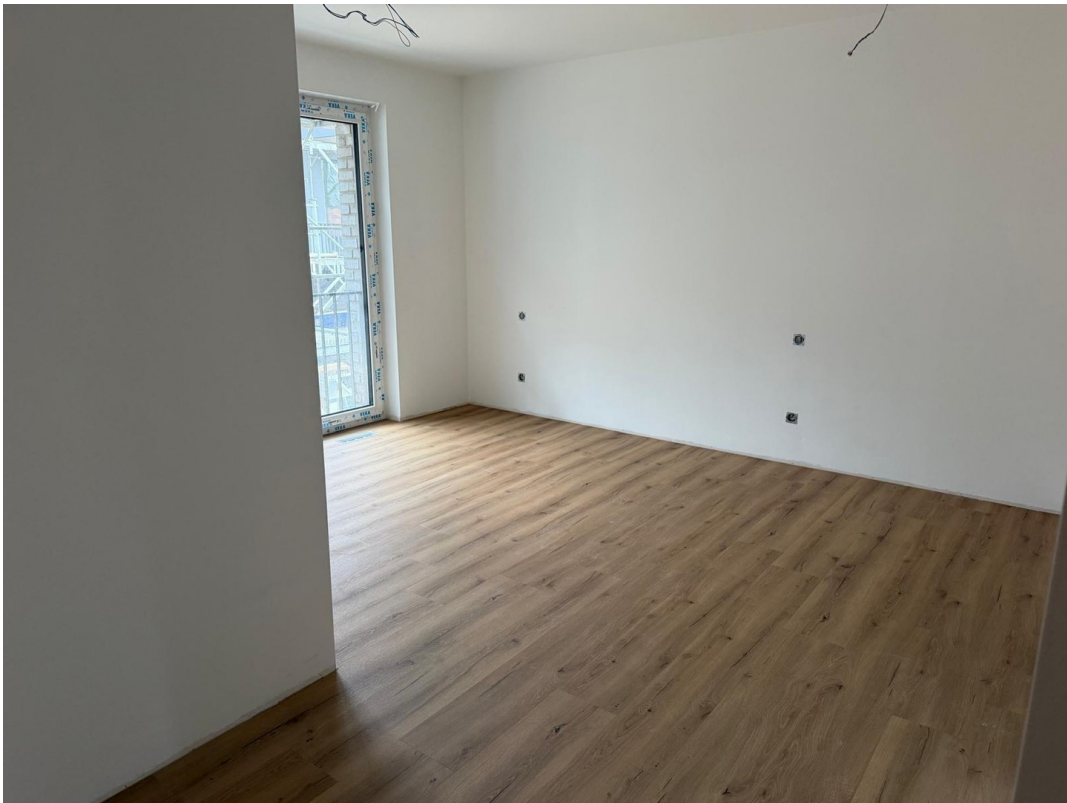
Raum 2 (aktueller Baustand)
