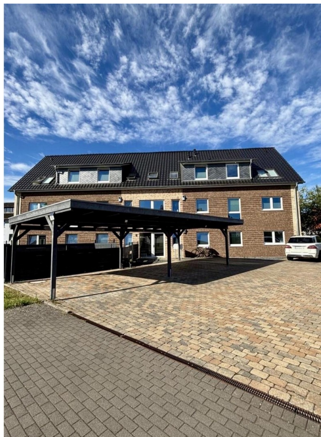
Außenansicht mit Carport
