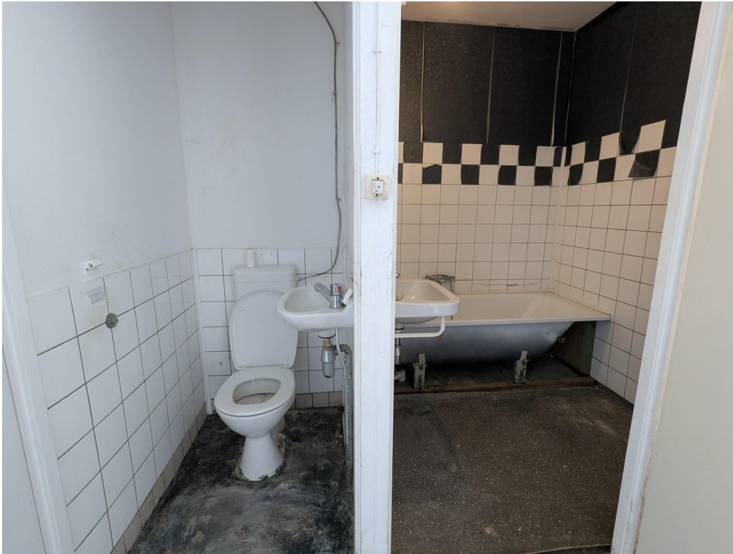
Bad und WC
