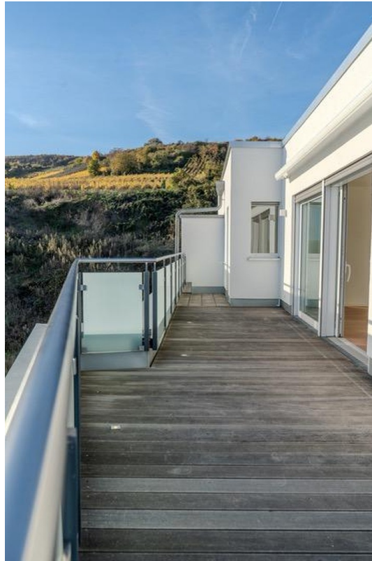
Dachterrasse mit Bangkirai
