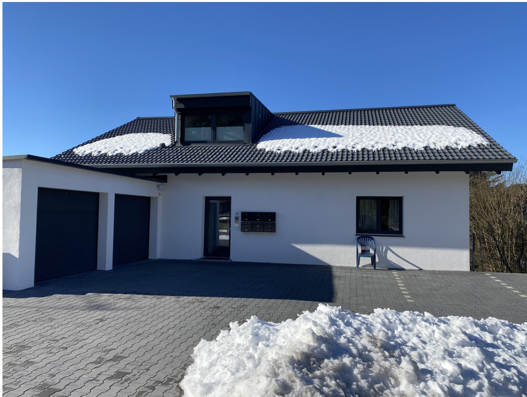
Außenansicht von vorne
