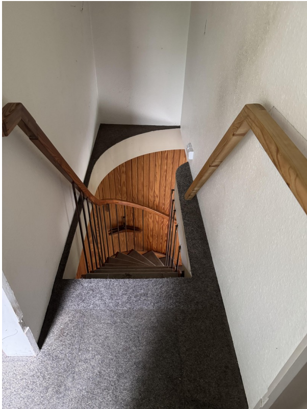
Treppe vom Dachgeschoß
