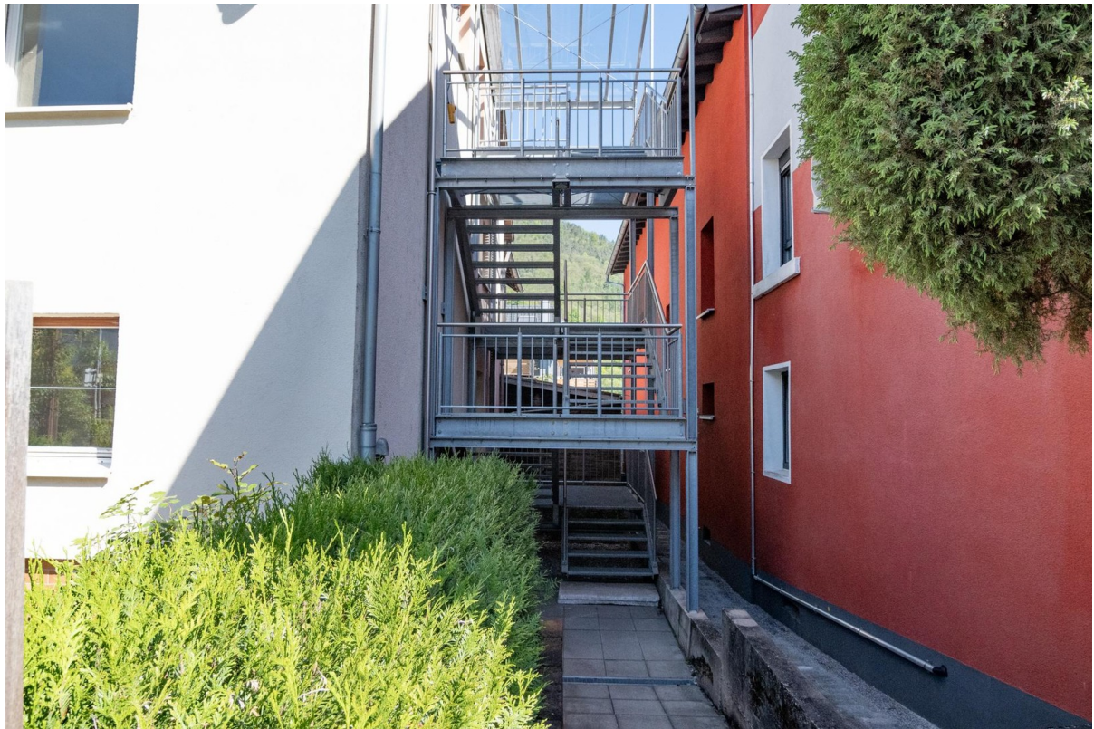
Zugang über Außentreppe
