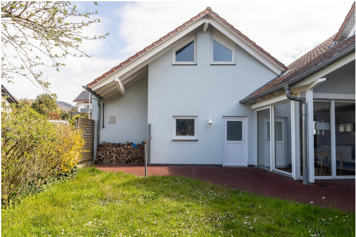
Haus rechts Innenhof
