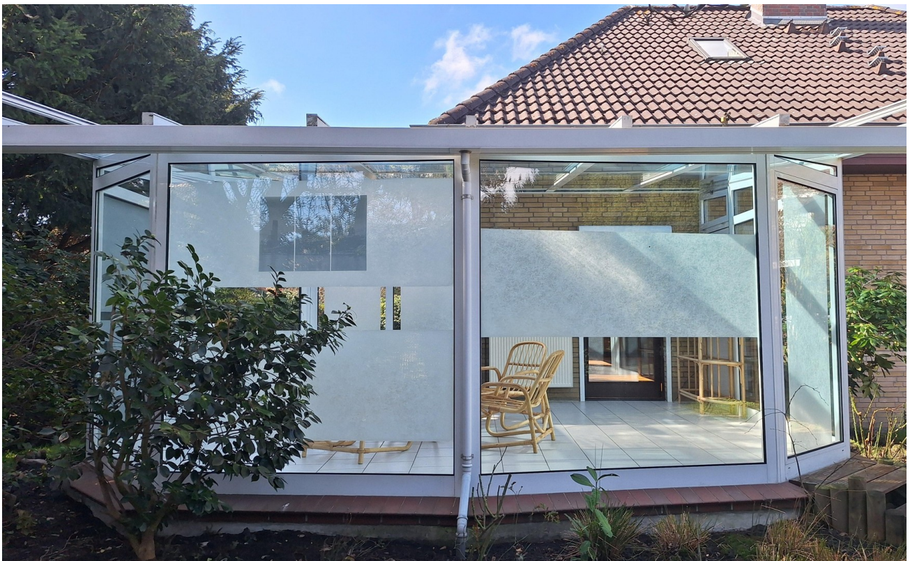
Wintergarten von außen
