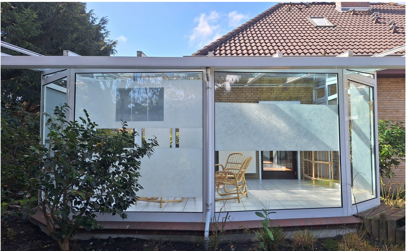
Wintergarten von außen
