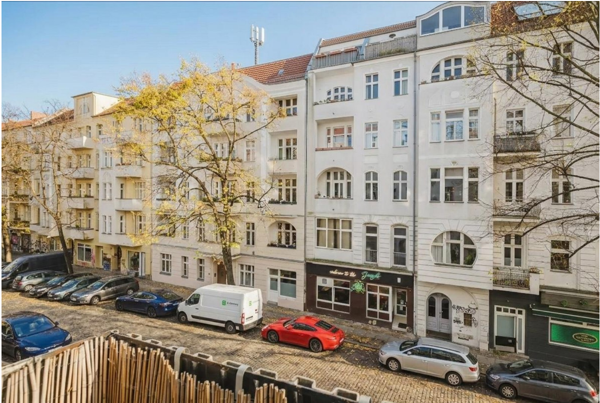
Strassenansicht von Balkon
