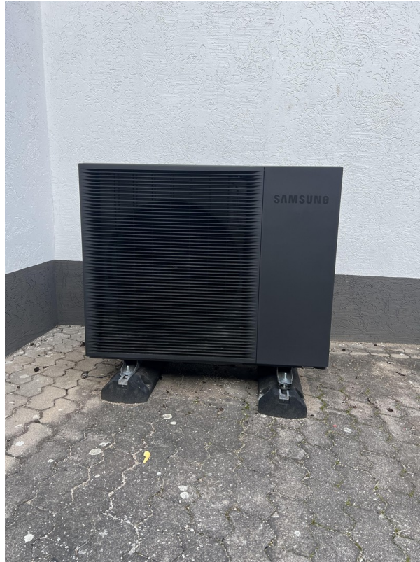
Wärmepumpe (Luft/Wasser)
