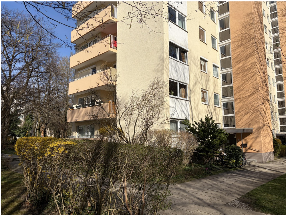
Balkon und Fenster von außen
