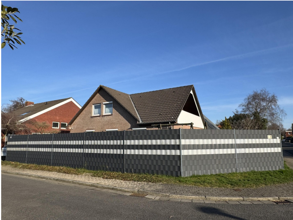
Außenansicht mit Sichtschutz
