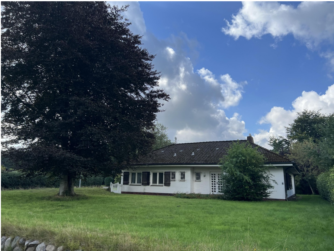
Nordseite des Hauses
