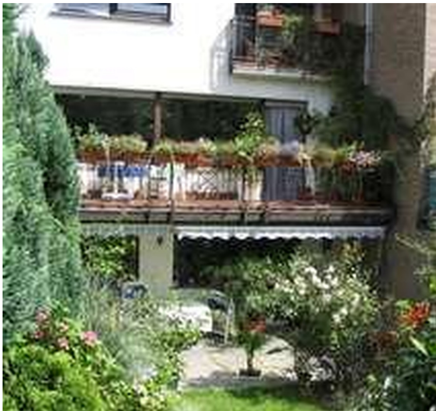
Hausansicht hinten(altes Foto)
