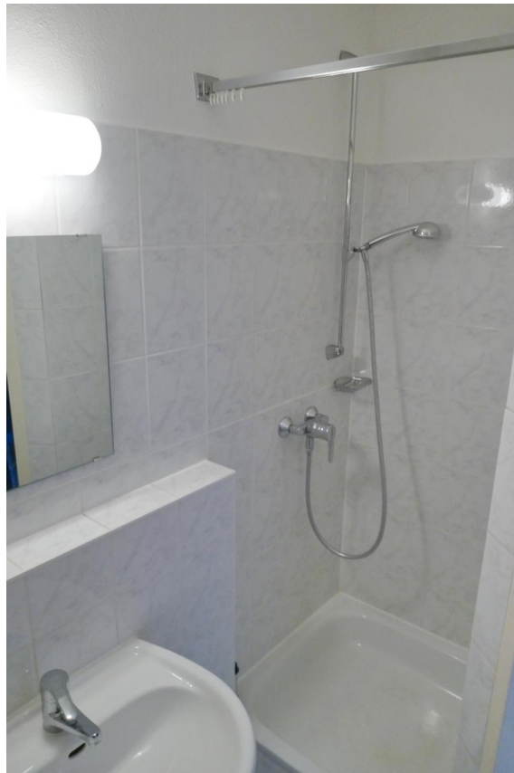
Bad mit Dusche / WC
