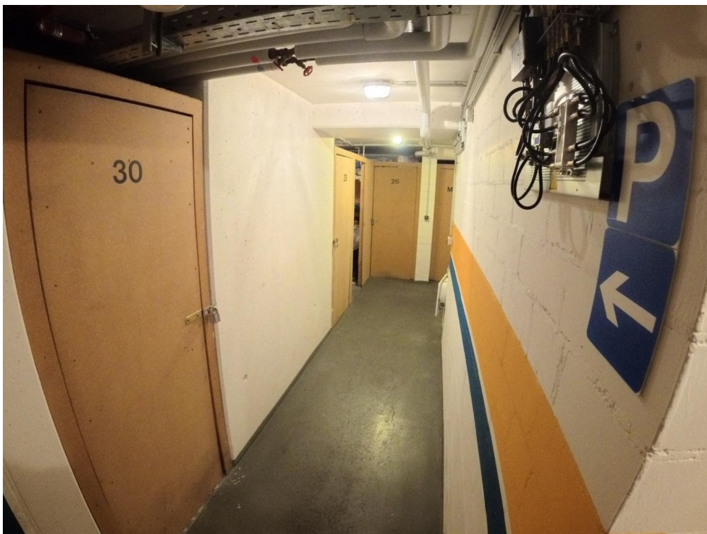
Kellerabteil Richtung TG
