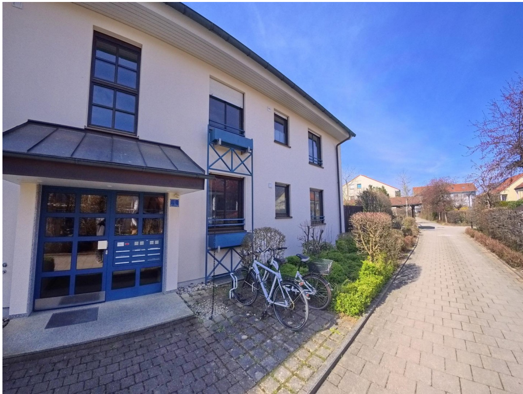
Eingang und Wohnung (rechts)
