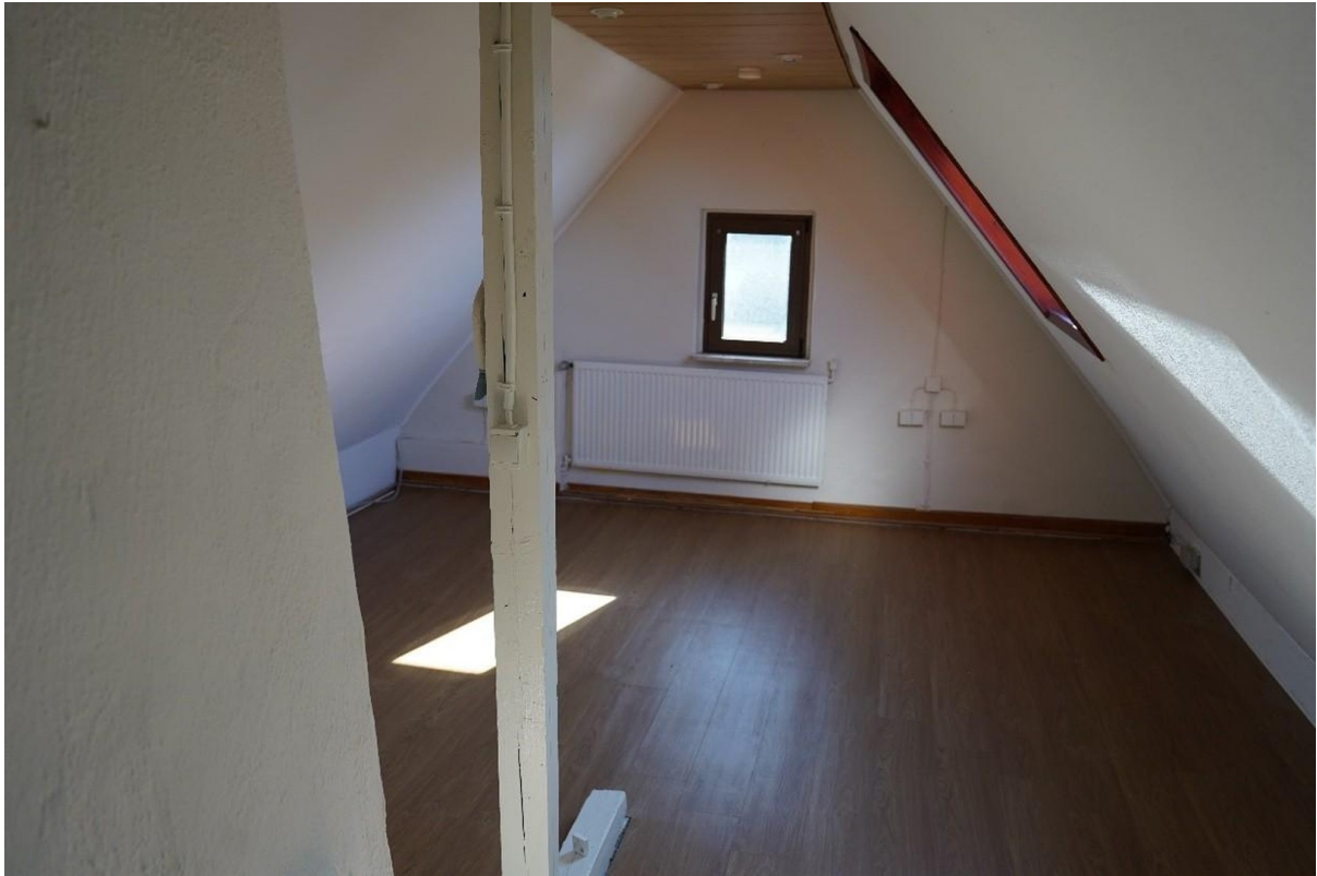
Speicher (Sicht zu Strasse)
