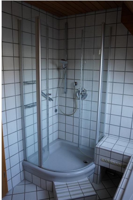
Dusche im Badezimmer
