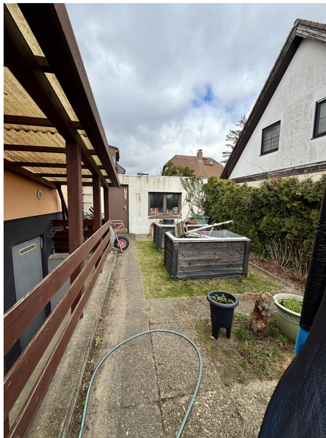
Außentreppe Keller & Garage
