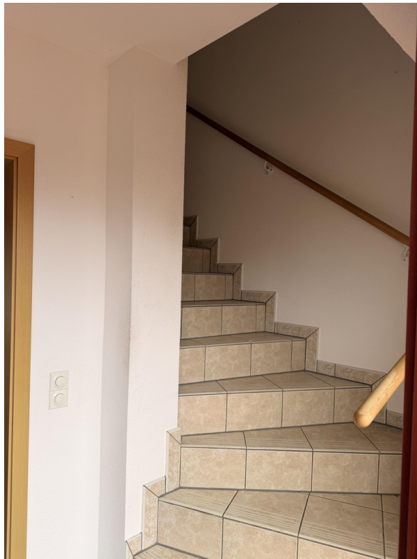
Windfang / Treppe zum OG
