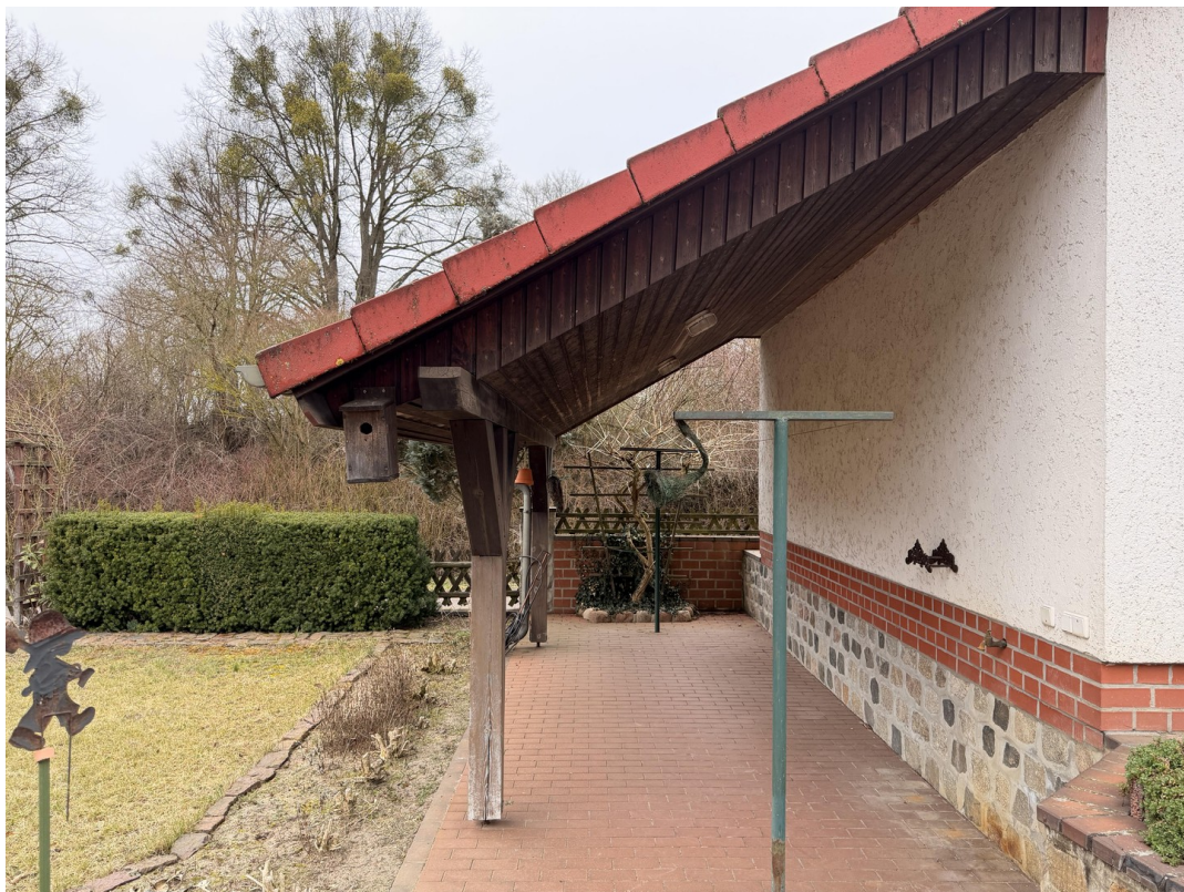
Terrasse / Trockenplatz Garage
