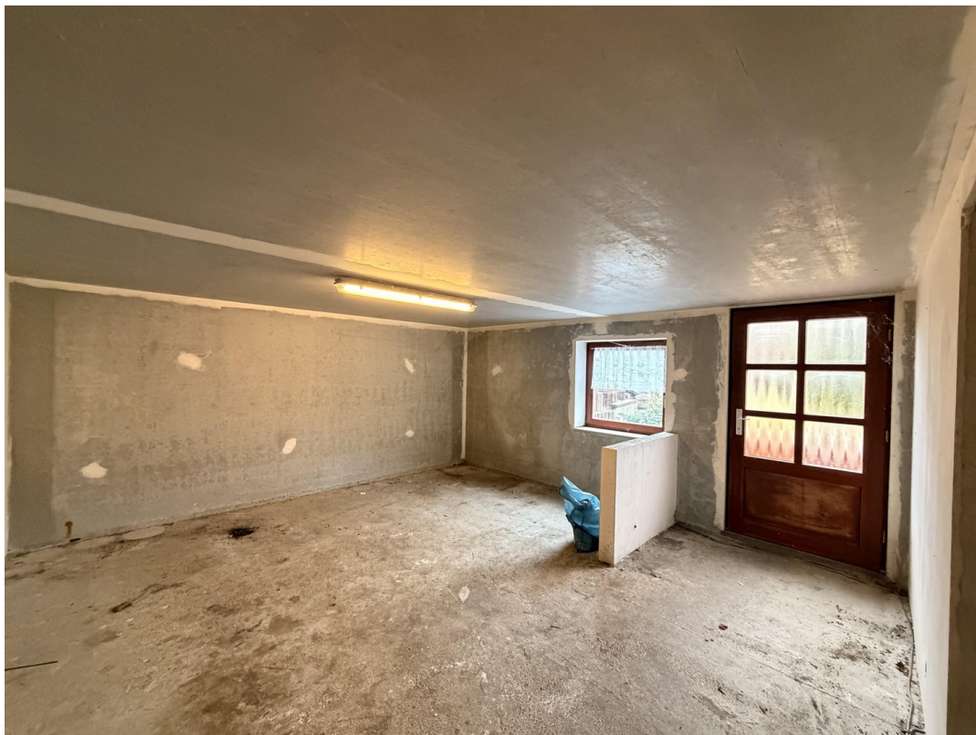
Keller 2 mit Zugangstür
