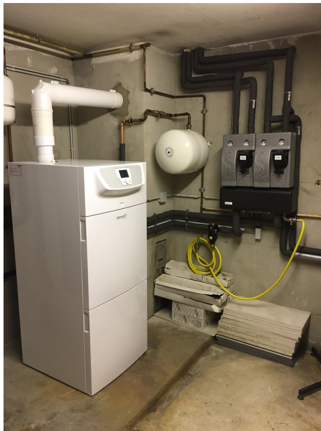
Gas-Brennwerttechnik aus 2017
