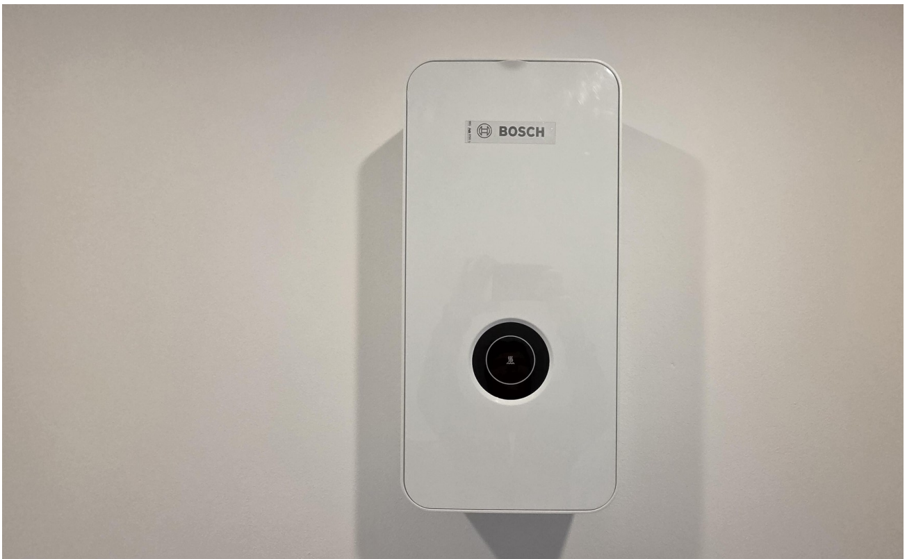
Durchlauferh. für Bad und Küch
