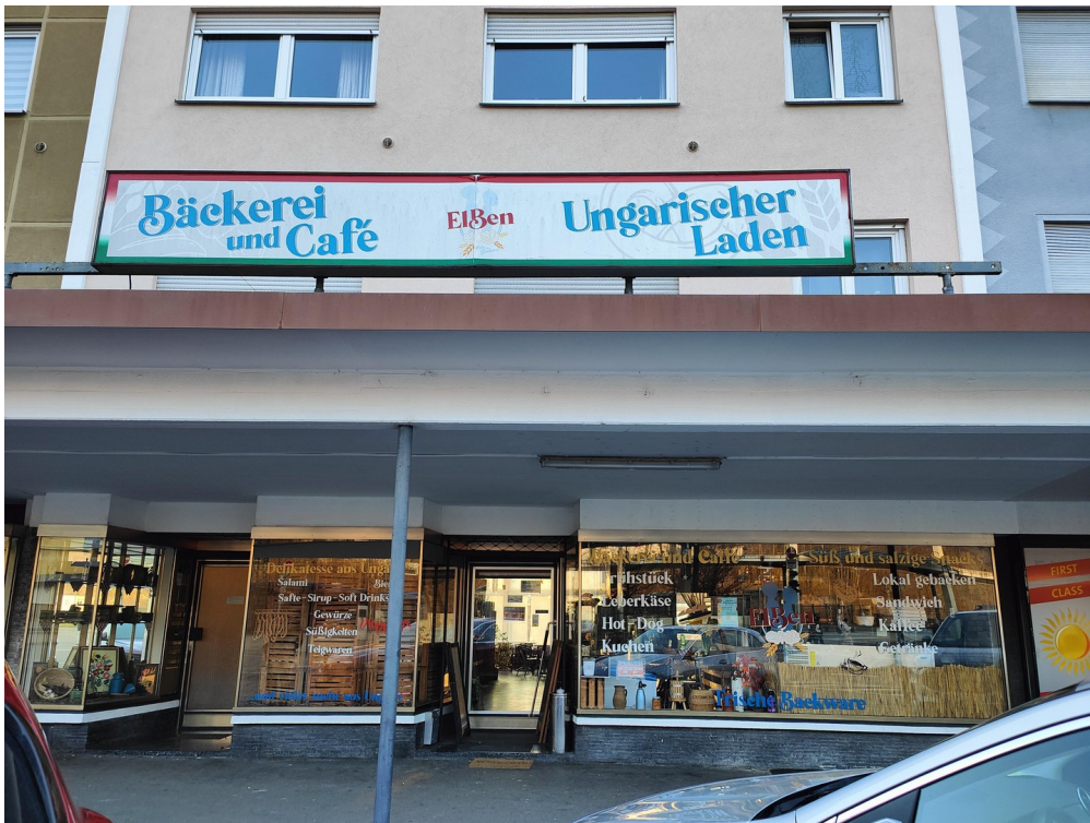
Werbeanlage auf Passagendach
