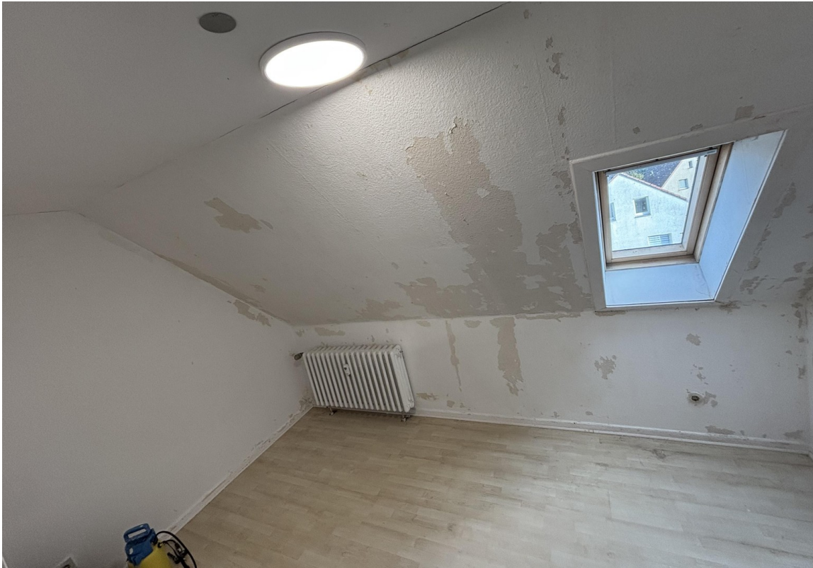
Spitzboden Raum 2-unrenoviert
