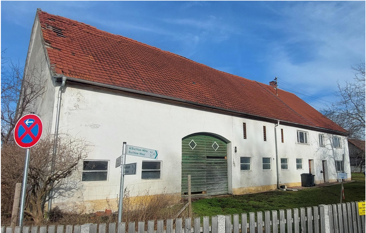
Südwest-Ansicht des Hofes
