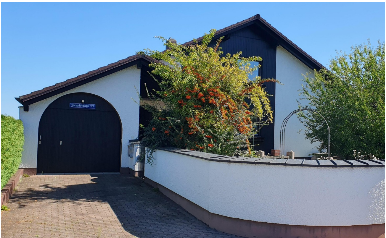
Außenansicht mit Einfahrt
