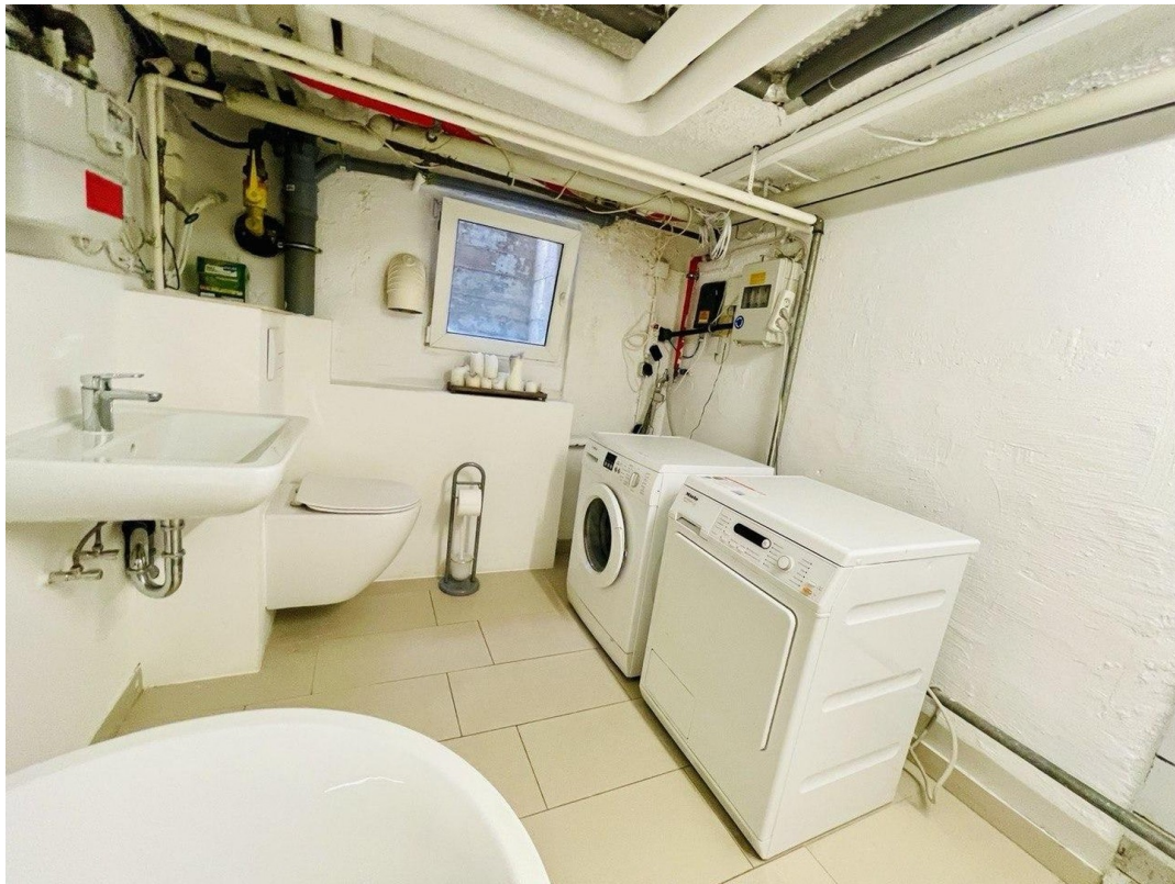
Bad / Waschraum im UG
