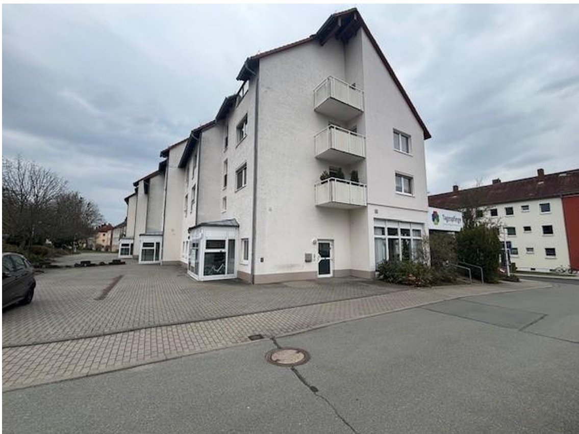
Aussenansicht von Stellplatz
