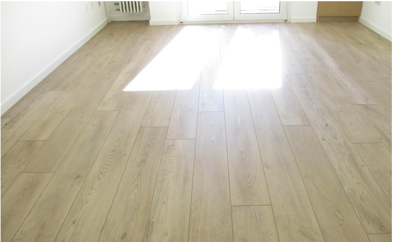
Bodenbelag Zimmer und Flure
