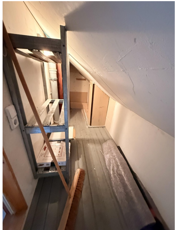
Abstellraum hinter Bad 2
