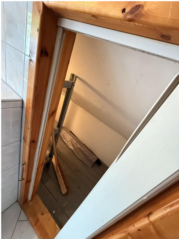
Abstellraum hinter Bad 1
