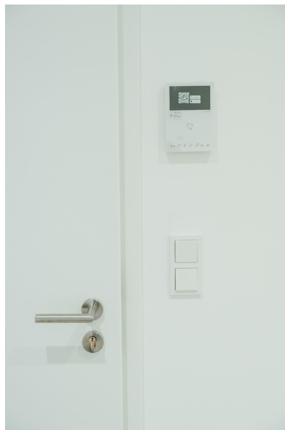
Bedienung Fußbodenheizung
